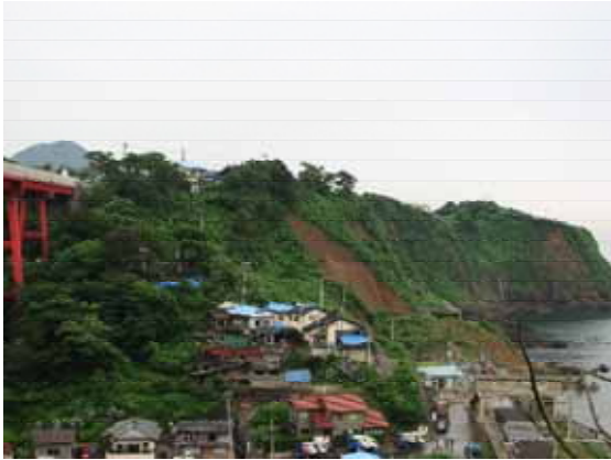
土砂崩落全景
