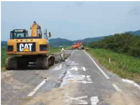
大河津分水・復旧箇所
