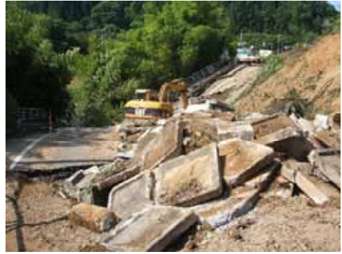
R 8 大積町千本町崩落箇所
