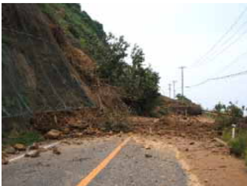
柏崎市椎谷 土砂崩落
