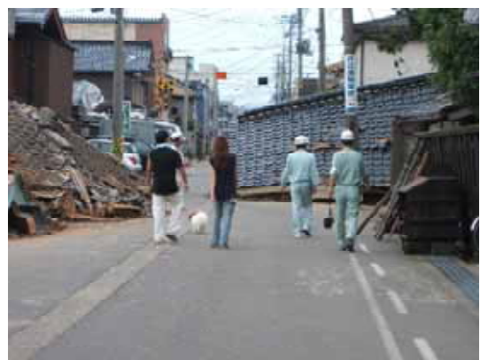
道路側に倒壊した家屋
