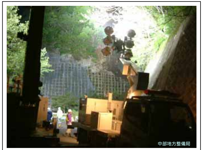
照明車(木曾上・岐阜国・中技) による照明活動
