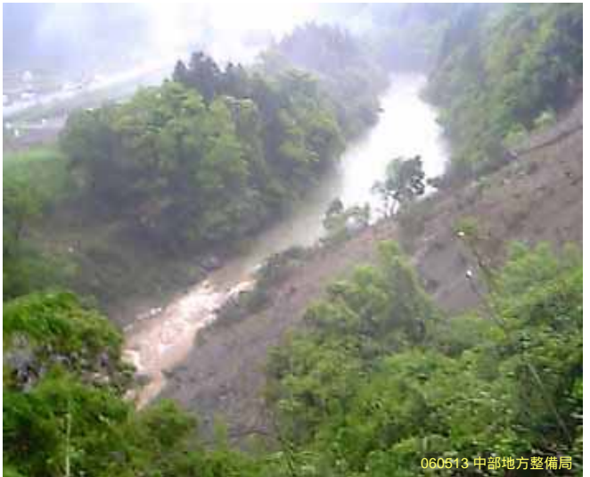
5月13日7:59頃の状況 (5月13日7:57大規模崩壊直後)
