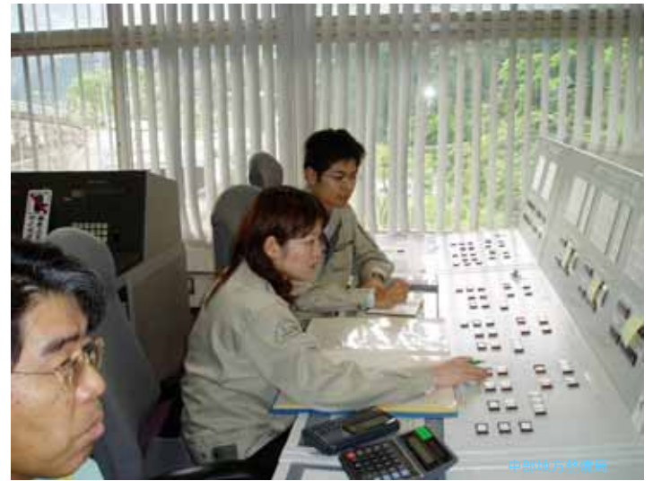
ダム操作状況
