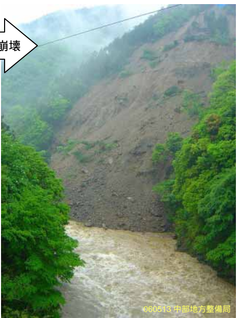
5月13日8時頃の状況 (5月13日7:57大規模崩壊直後)
