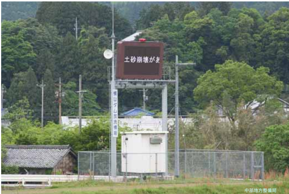
ダム放流警報表示装置による河川利用者などへの注意喚起の状況
