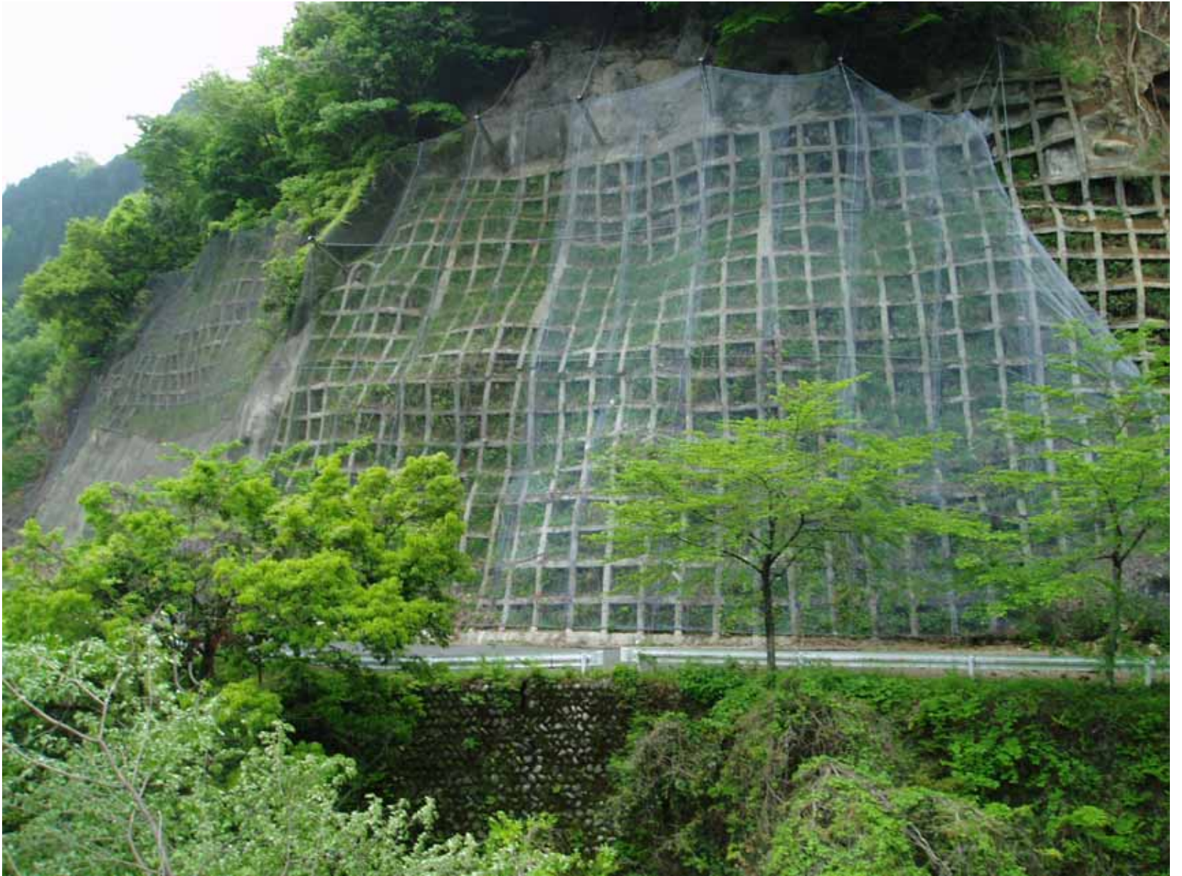
地すべりブロック下部の法枠
