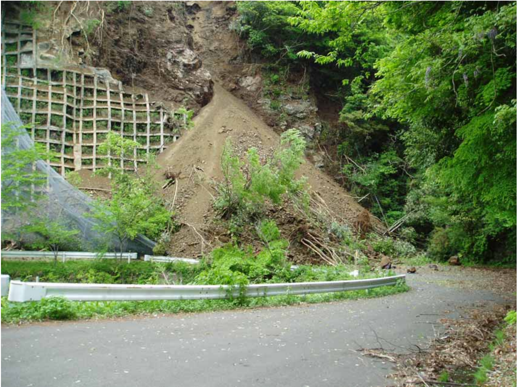
路上への崩落
