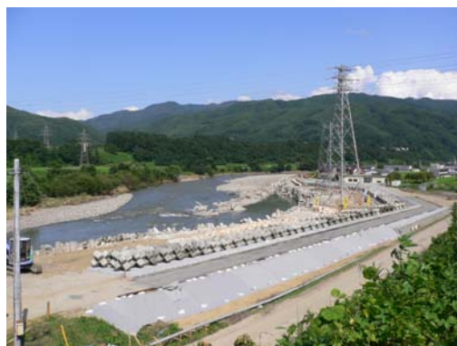
⑧7/30 15時 大型連節ブロック張完了
