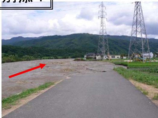
①7/19 堤防決壊直後(上流側から)
