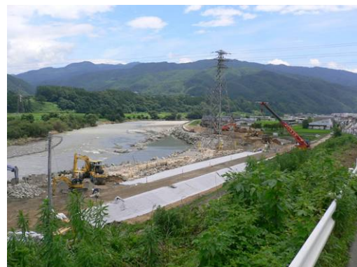
⑦7/27 12時 進入路を除き築堤盛土完了
