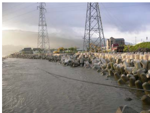
④7/22 17時 緊急復旧工事の根固ブロック投入状況
