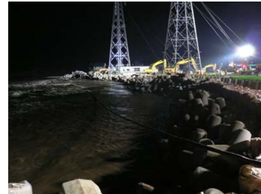
③7/21 19時30分 応急復旧工事完了
