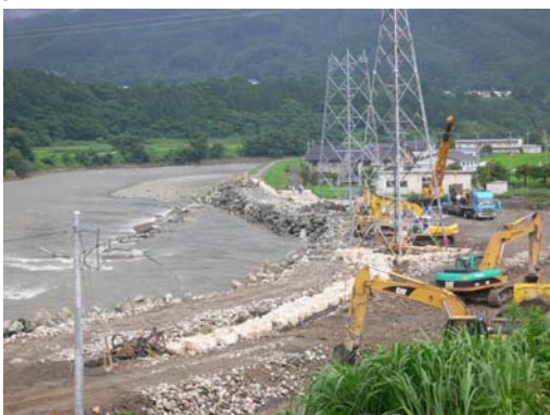
⑦7/24 15時 緊急復旧工事の 根固ブロック投入完了
