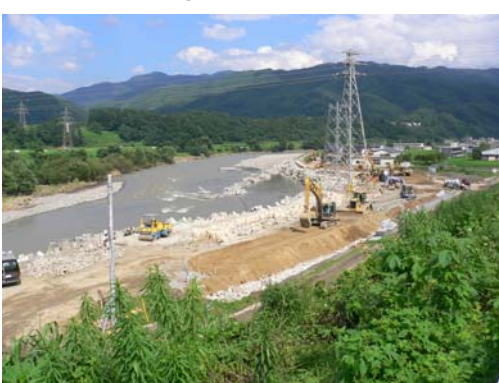
⑧7/26 15時 築堤盛土施工中
