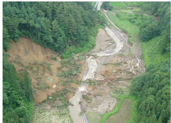
⑦小横川【山腹崩壊】 7/20 11時撮影
