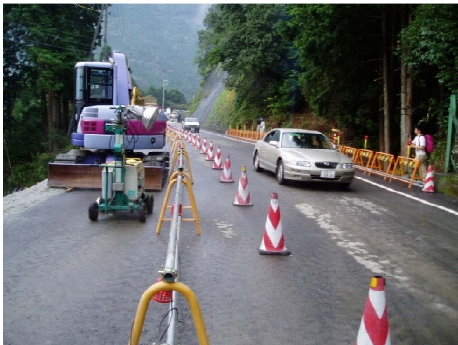
国道42号 海山町、10月2日午後3時 片側交互通行で交通解放
