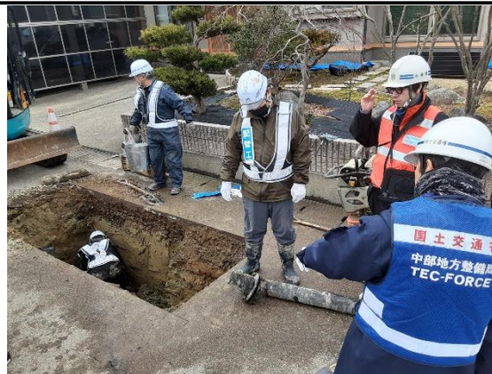
【七尾市】 和倉地区配水管修繕工事状況 の確認（上水）
