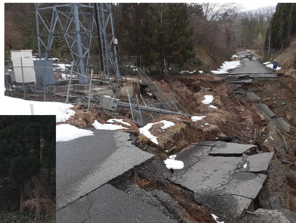
珠洲市道 道路の損壊状況 （盛土部が崩落委）
