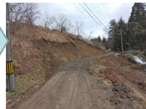
道路啓開、水道管復旧状況(輪島市町野町)
