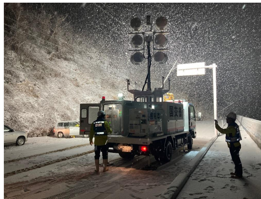
輪島市南志見にて照明作業
