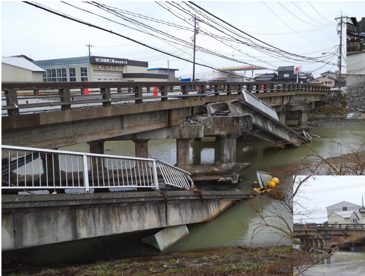
珠洲市道676号線(旧国道249号) 鵜飼大橋の損傷、橋側歩道橋の落橋
