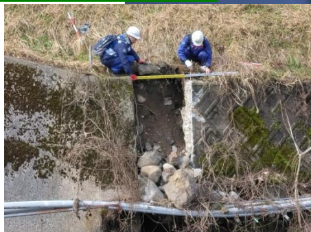
被災状況調査班：河川班 珠洲市大谷川にて現地調査
