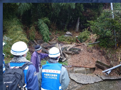
被災状況調査班 砂防班 輪島市における現地調査
