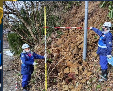
被災状況調査班 砂防班 輪島市における現地調査
