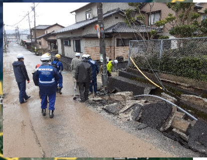
応急対策班 水道支援班 七尾市における 資材納入立会
