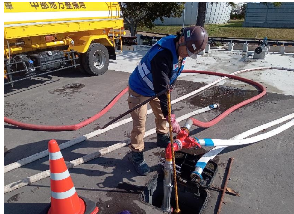
金沢市にて補給(取水)【応急対策班(給水支援)】
