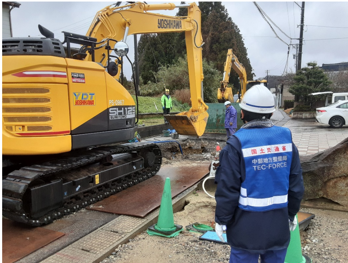
七尾市内にて現地確認【上下水道支援班】
