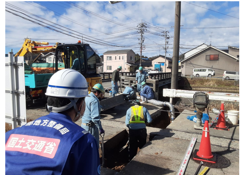
七尾市内にて現地調査【水道支援班】
