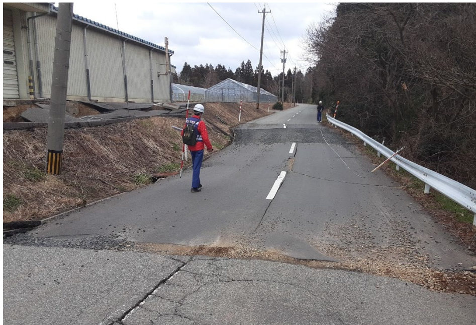
珠洲市内にて現地調査【道路班】
