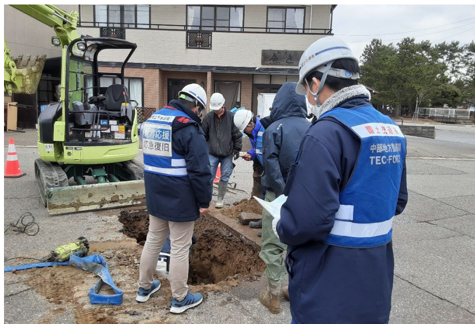
七尾市内にて現地調査【水道支援班】
