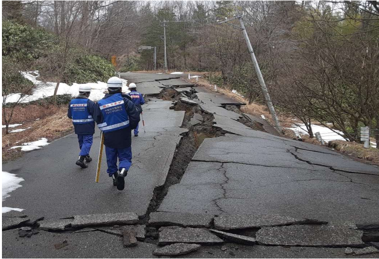
珠洲市内にて現地調査【道路班】
