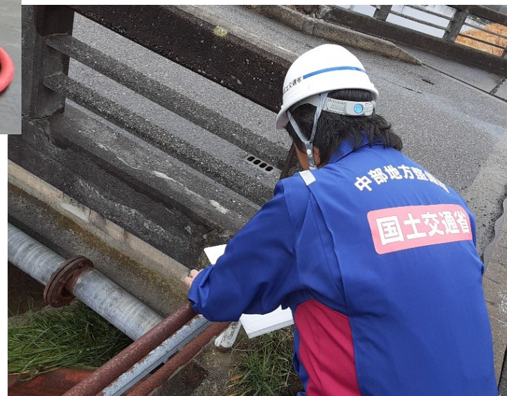
七尾市内にて現地調査【水道支援班】
