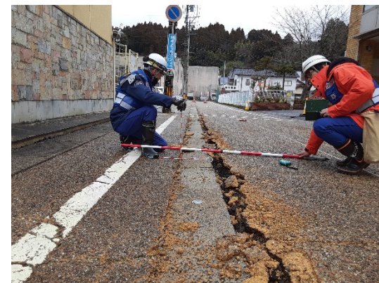
能登町内にて被災状況調査 【道路班】
