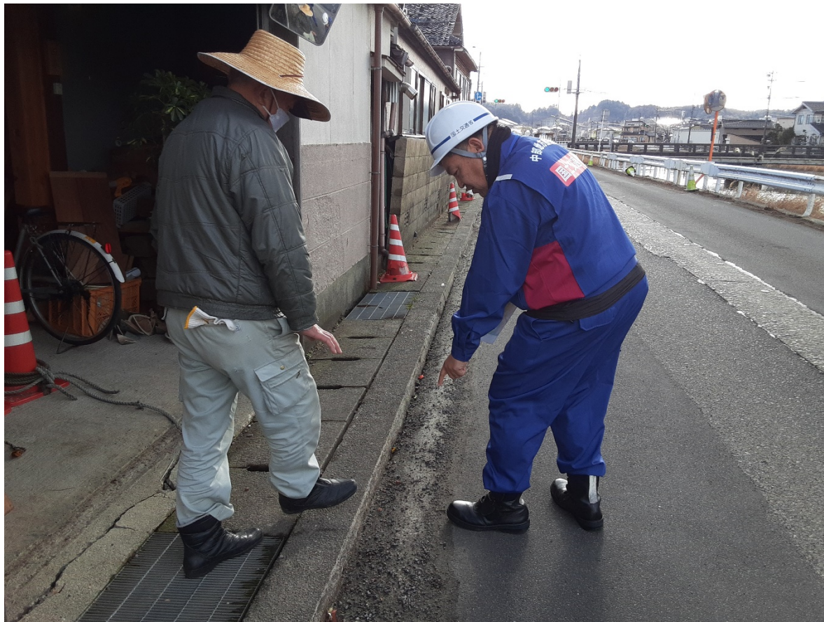
七尾市内にて現地調査 【水道支援班】
