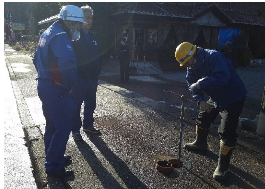
七尾市内にて現地調査【水道支援班】
