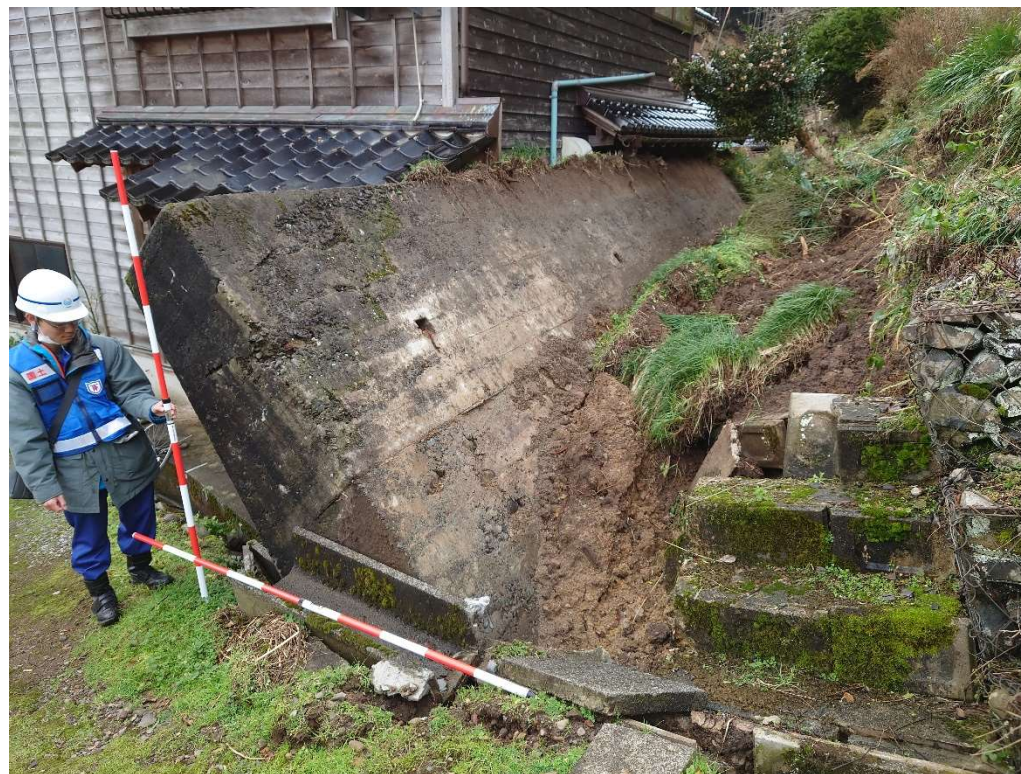
○輪島市における被害状況調査【砂防班】
