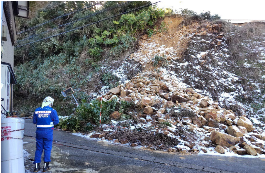
輪島市における被害状況調査【砂防班】
