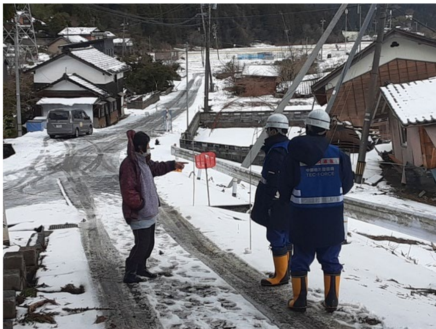
珠洲市における被災状況調査【道路班】
