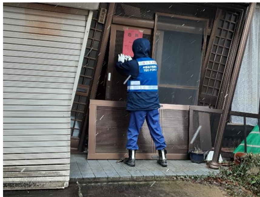
能登町における危険度判定調査【建築班】
