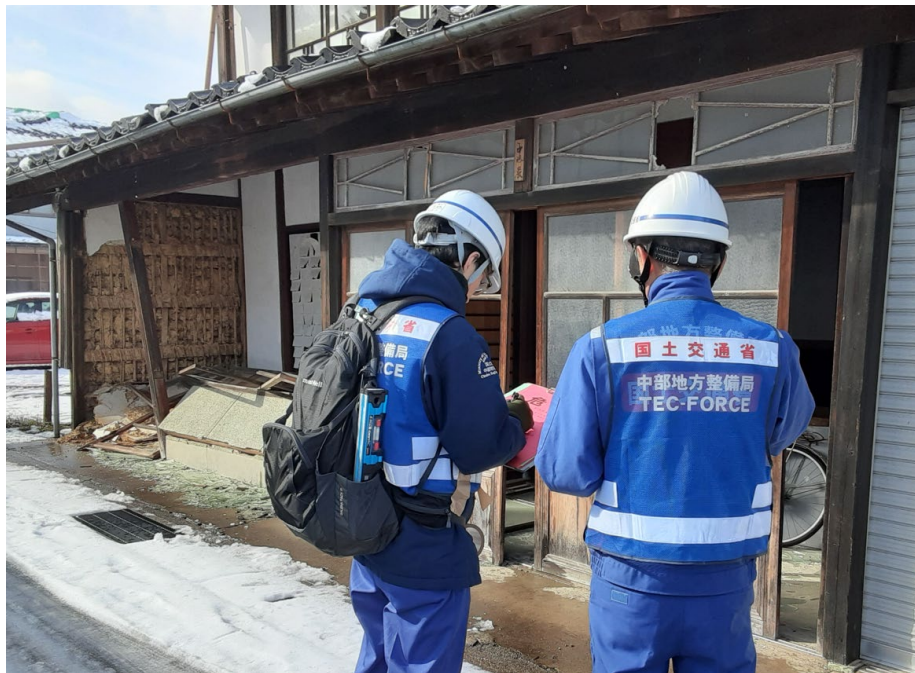
建築班による能登町における危険度判定調査
