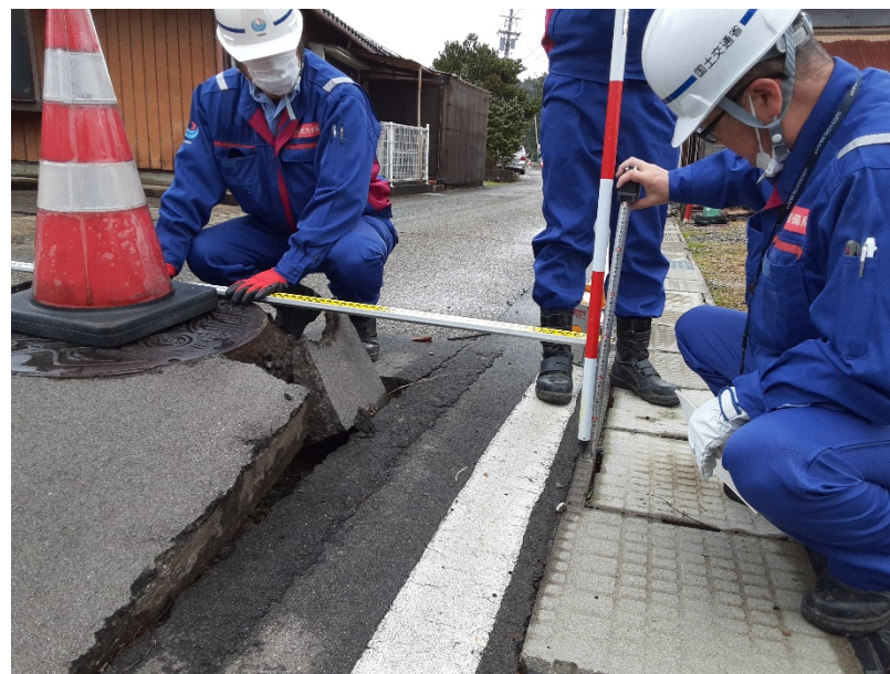
道路班による現地調査(七尾市)
