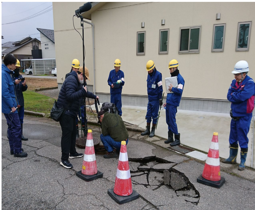
水道支援班による七尾市での取材対応
