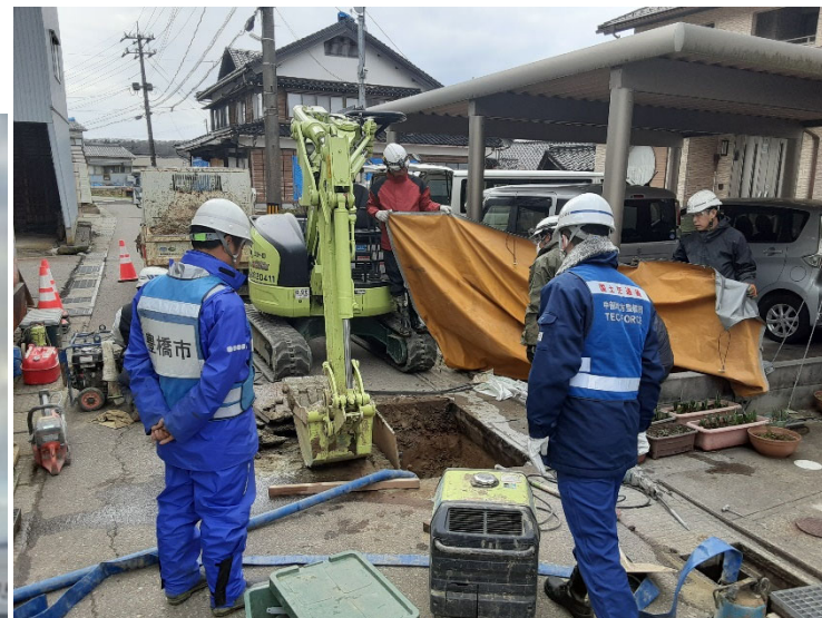
七尾市にて現地確認【上下水道支援班】
