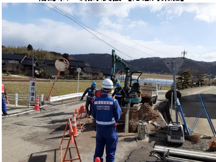
志賀町にて現地確認【上下水道支援班】
