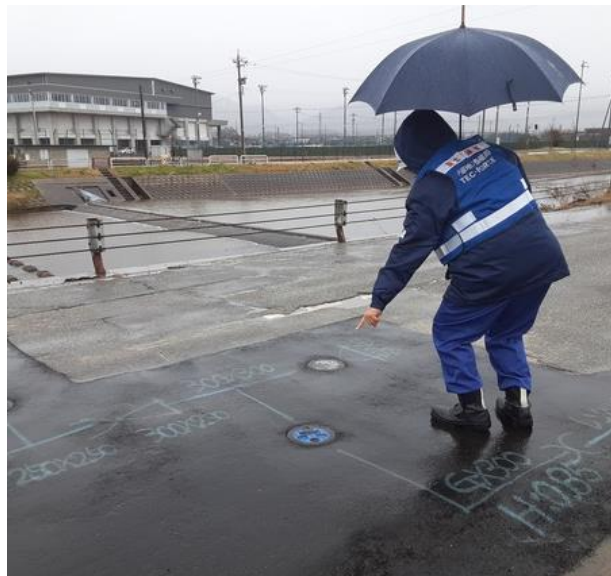
七尾市内にて現地調査【水道支援班】
