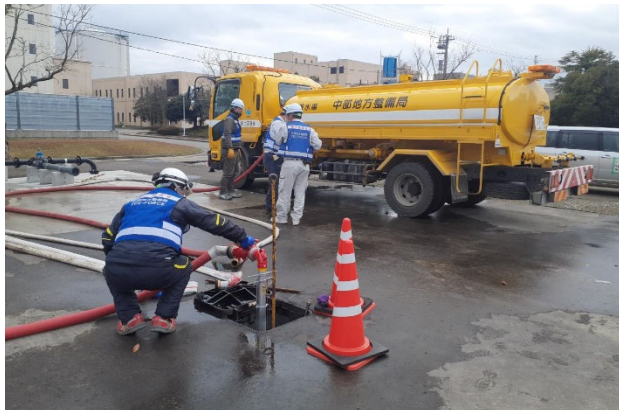
金沢浄水場にて補給作業【給水支援班】
