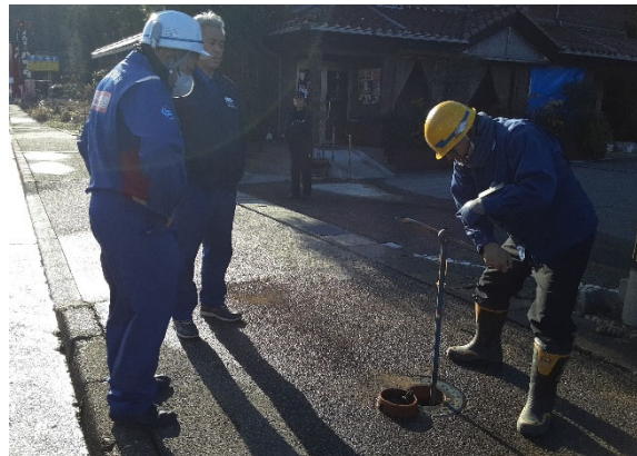
七尾市内にて現地調査【水道支援班】
