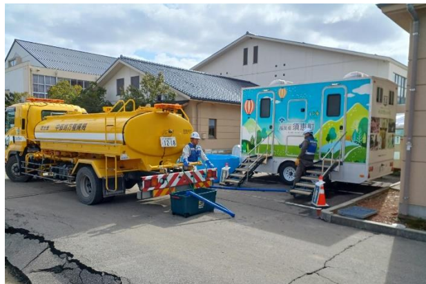
輪島市・珠洲市で給水作業【給水支援班】
