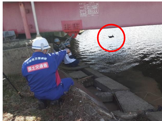
七尾市内のドローンによる被災状況調査【水道支援班】
