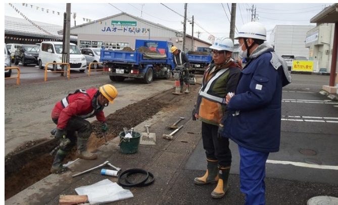
七尾市内復旧工事現場確認【水道支援班】
