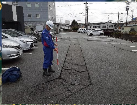
応急対策班(水道支援) 七尾市における水道の現地調査
