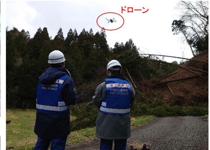
輪島市内におけるドローンによる被災状況調査【砂防班】
