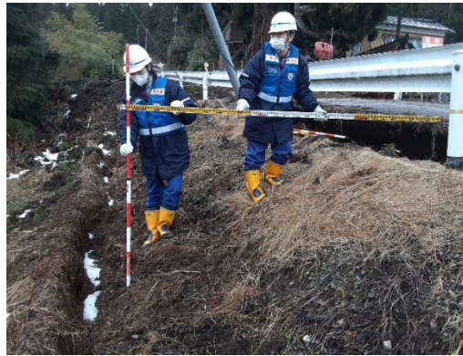
珠洲市内被災状況調査【道路班】
