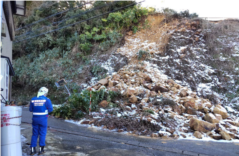
輪島市における被害状況調査【砂防班】
