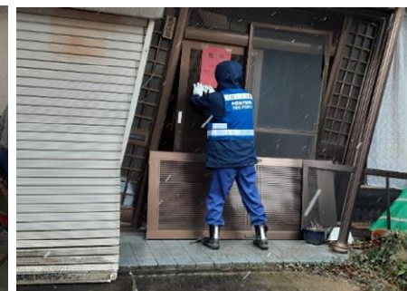
能登町における危険度判定調査【建築班】
