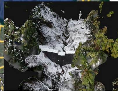
被災状況調査班 砂防班 ドローン撮影による点群データ作成
