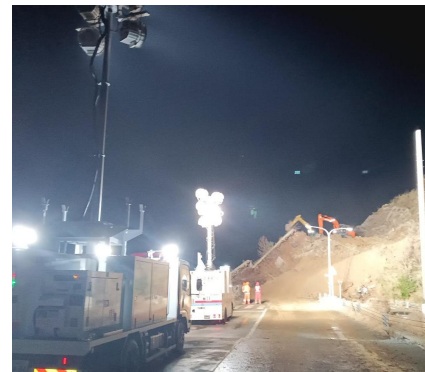
珠洲市における照明車支援
