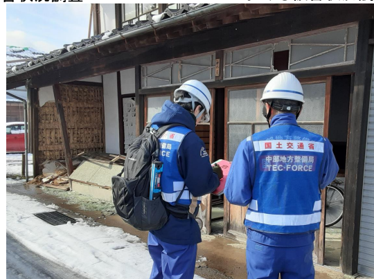
建築班による珠洲市における危険度判定調査
