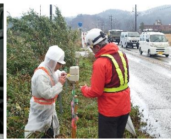
モバイルトラックの設置(写真は七尾市国道249号)
