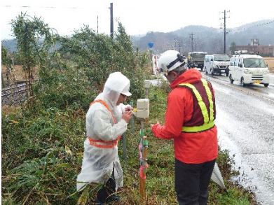
モバイルトラックの設置(写真は七尾市国道249号)
