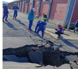
港湾班による七尾港における被害状況調査
