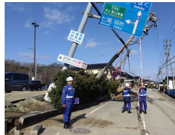
道路班による石川県内灘町における被害状況調査
