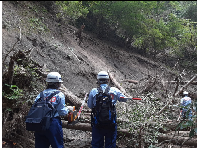
【被災状況調査(島田市 川根)】
