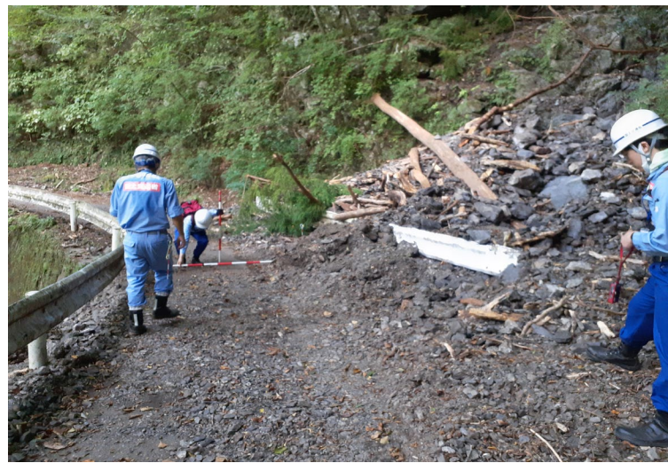
【被災状況調査(川根本町 千頭)】
