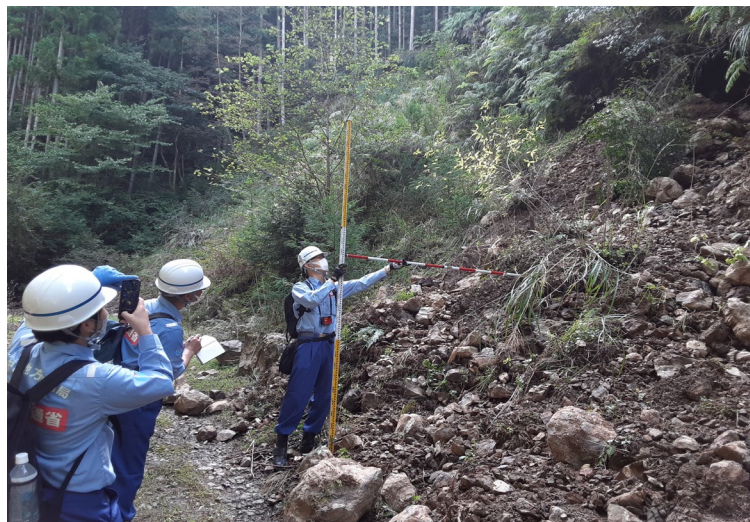
【被災状況調査(川根本町 下泉)】
