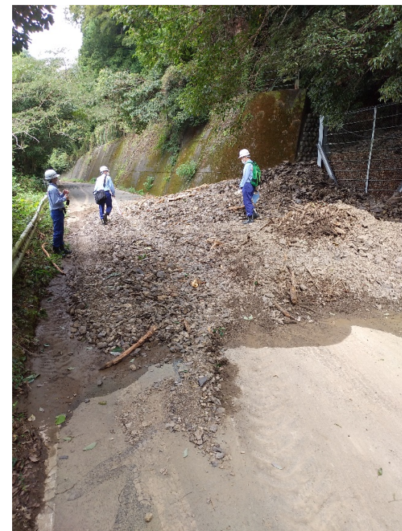
【被災状況調査(川根本町)】
