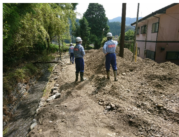
【被災状況調査(島田市)】
