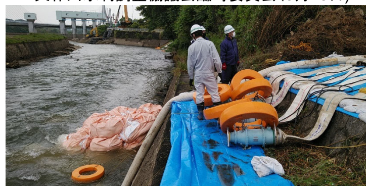
ポンプ設置作業状況(5月21日)
