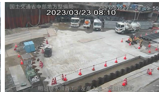
明治用水頭首工 左岸上流 豊田市室町
