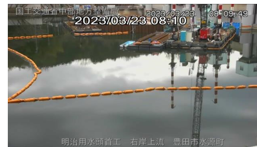
明治用水頭首工 右岸上流 豊田市水源町
