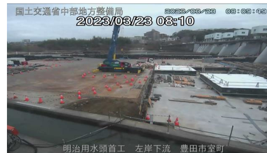
明治用水頭首工 左岸下流 豊田市室町
