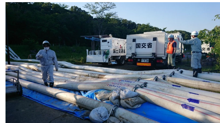
ポンプ設置状況(5月29日)
