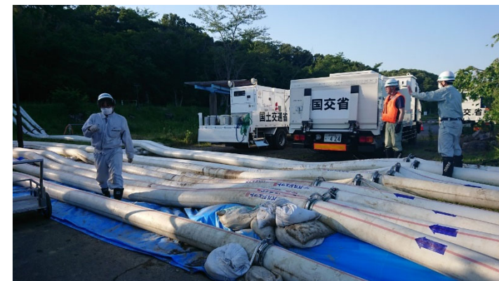
ポンプ設置状況(5月29日)
