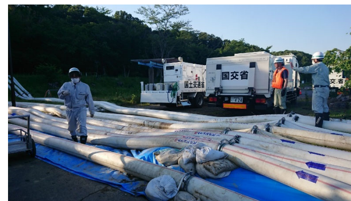
ポンプ設置状況(5月29日)
