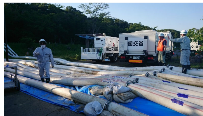
ポンプ設置状況(5月29日)
